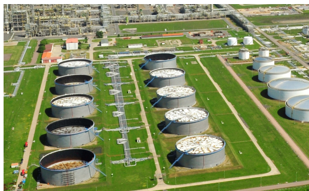
Kläranlage einer Raffinerie
